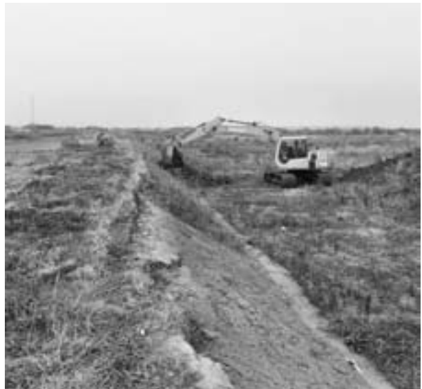
遺跡保護工事状況
