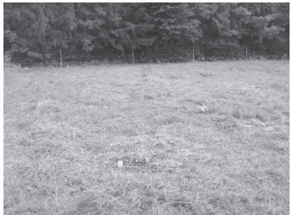
▲トレンチⅢ埋戻し終了 西北→
