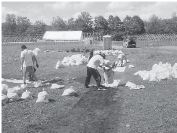
▲トレンチⅢ埋戻し 東南→
